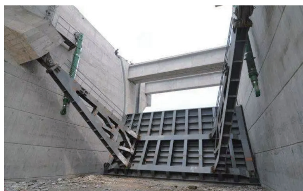
图2 水库闸门的框架加固
