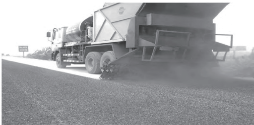
图1 同步碎石封层施工洒布现场图
