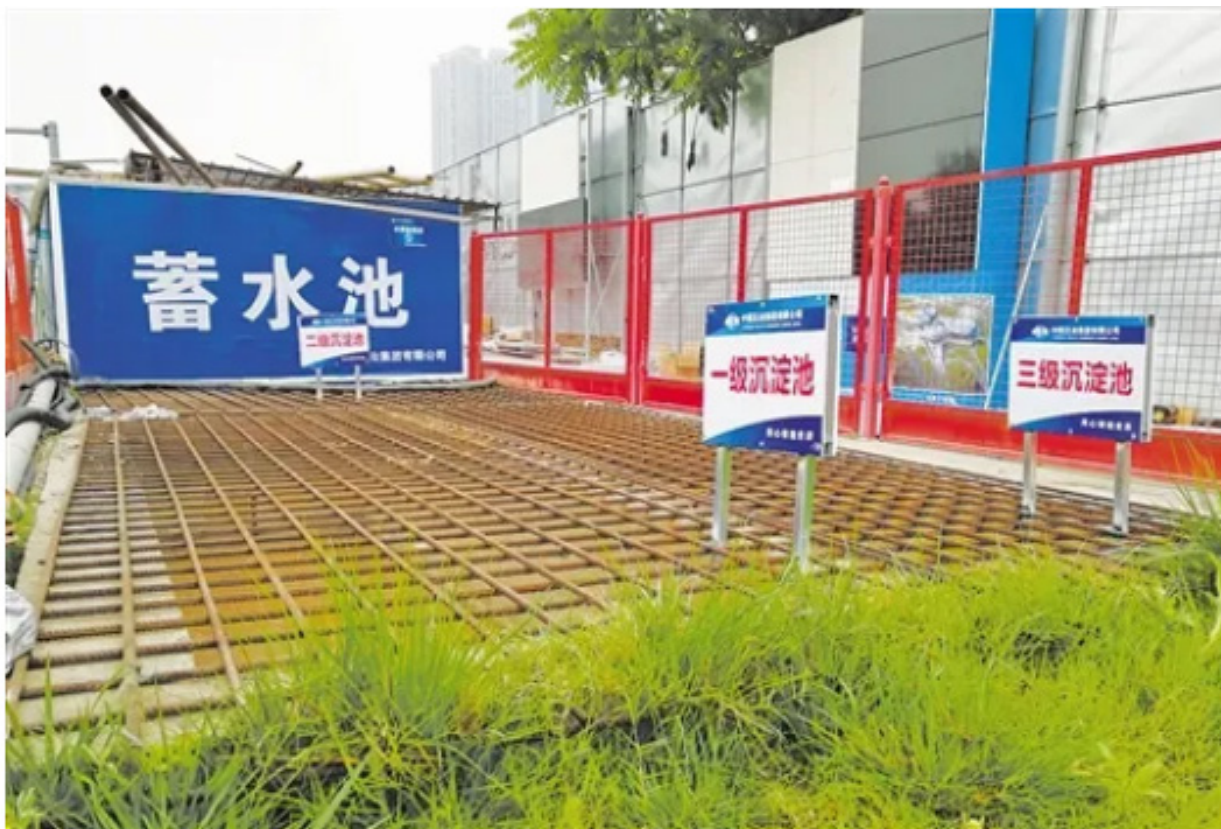
图 1：施工场地设置蓄水池
