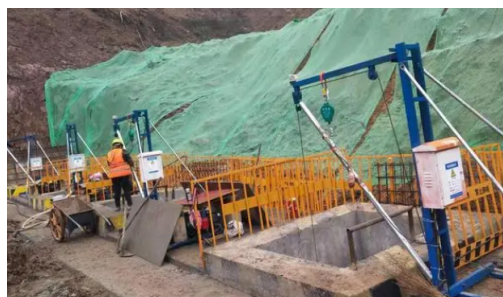
图3 抗滑桩施工
