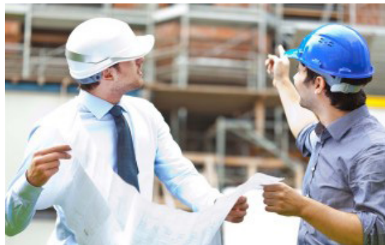
图一: 图为在施工现场开展监理工作。
