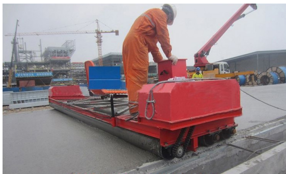
图 1 摊铺混凝土
