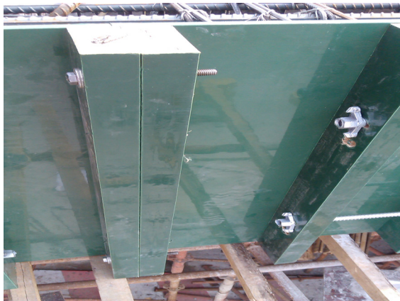
图 4：定型模板衔接拼缝节点连接图
