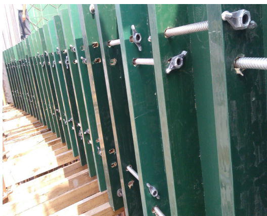
图 2：定型模板现场组装图
