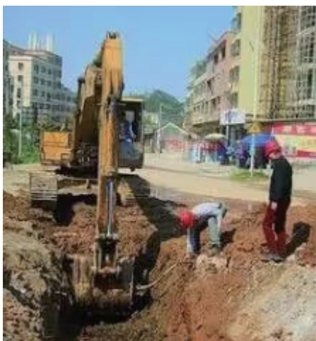
图一市政现场管理
