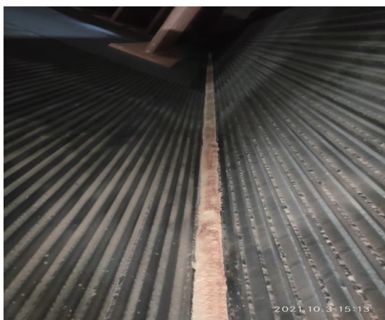
图3：双面水冷壁和水冷壁夹角填充浇注料。
