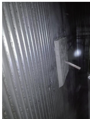
图一（炉膛压力测点让管位置布置浇注料）
