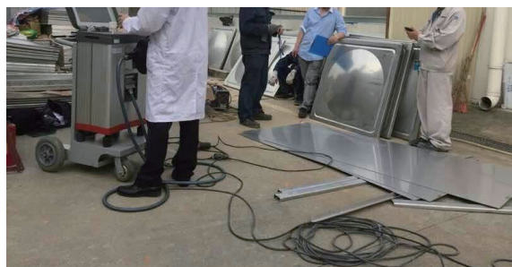
图 1 现场钢筋检测
