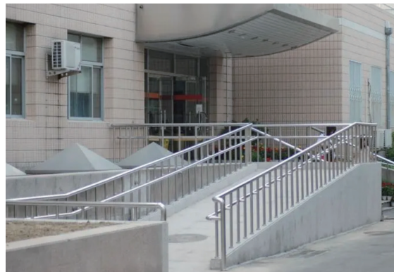
图1 建筑无障碍坡道设计
