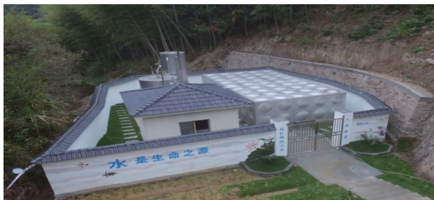
图1 农村饮水安全工程
