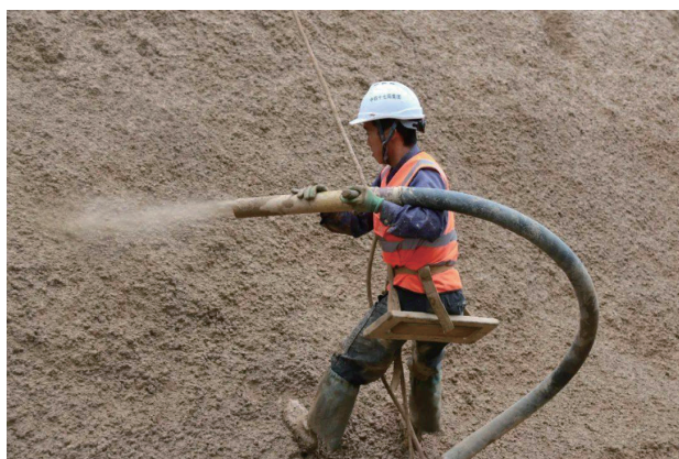
图 2 混凝土喷射
