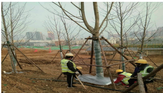
图1 大型树木支撑和固定
