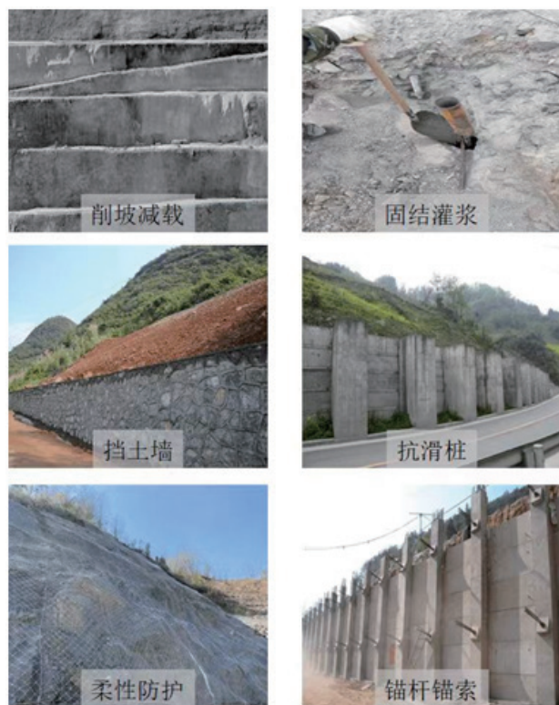
图2 滑坡防治措施示意图
